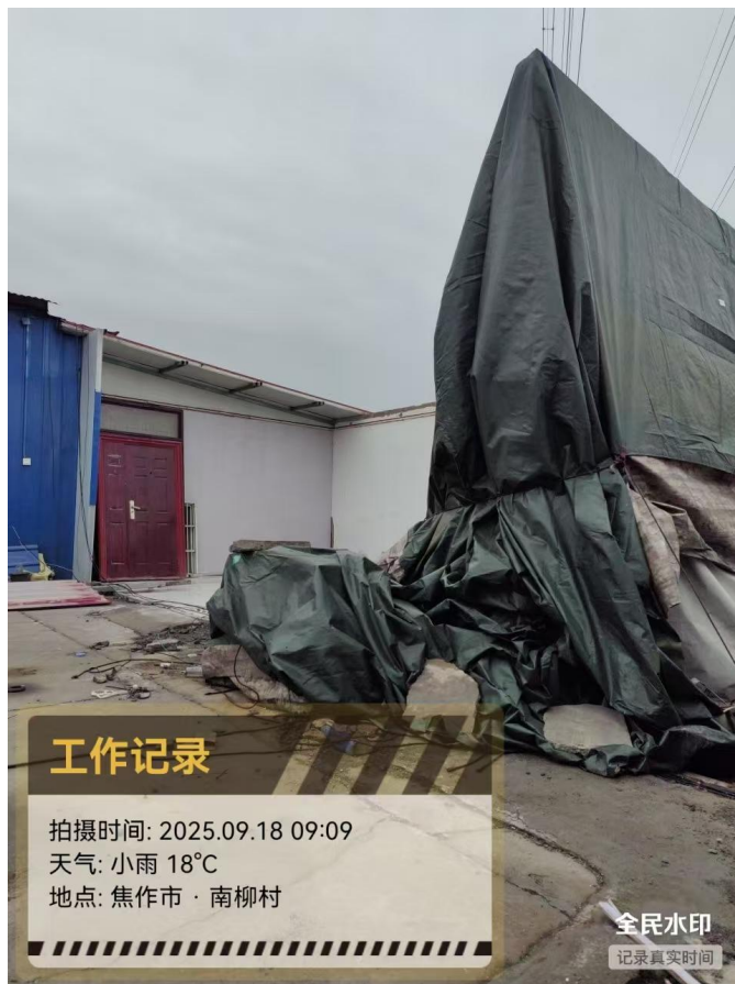
企业已拆除现场实况
