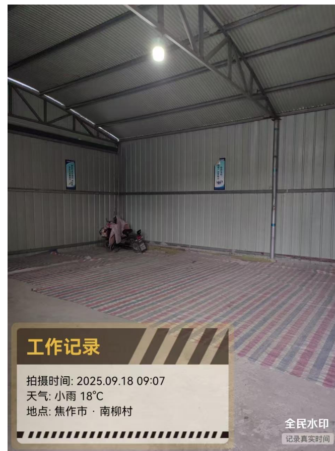
本项目拟建设区域现状
