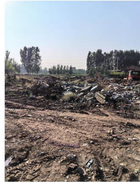
泵站及调蓄池现状
