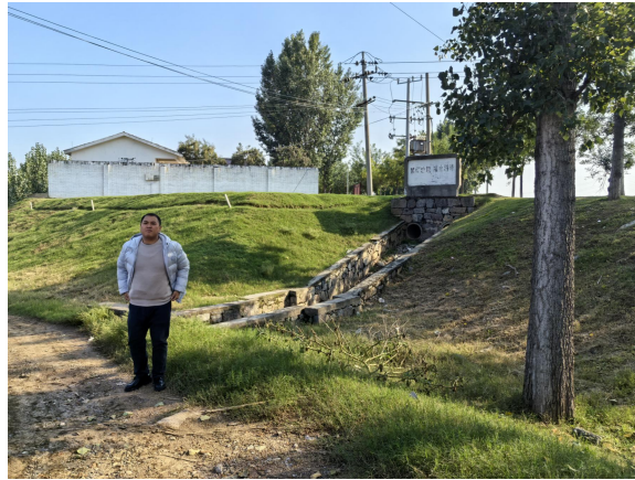
附图三十四 工程师现场踏勘照片
