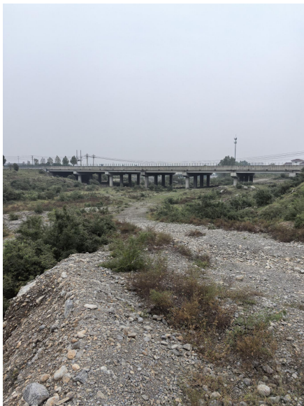
云阳河拟施工段现状
