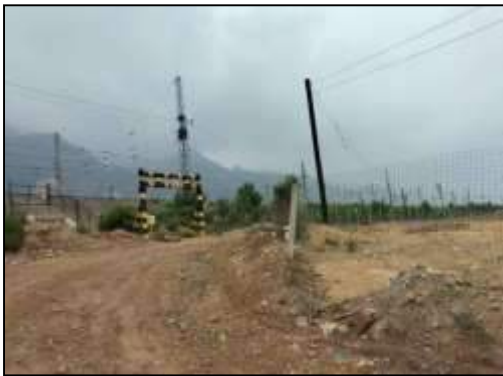
厂址北侧焦枝铁路
