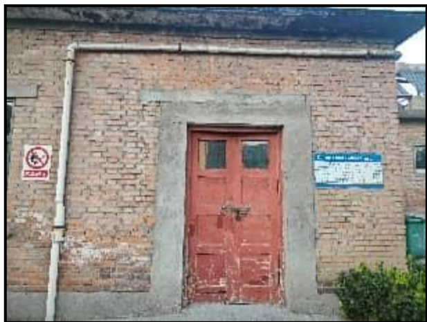
现有危废暂存库
