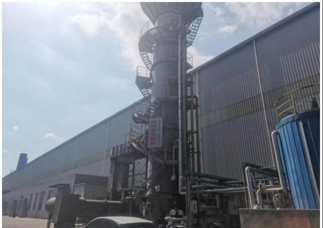
现有石墨化车间及脱硫塔
