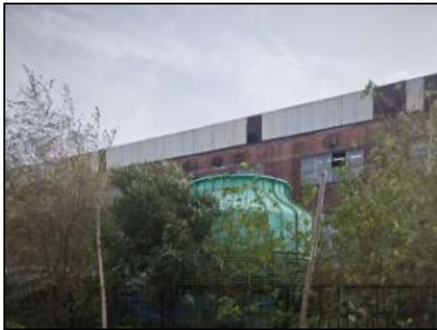
本次扩建工程拟利用车间
