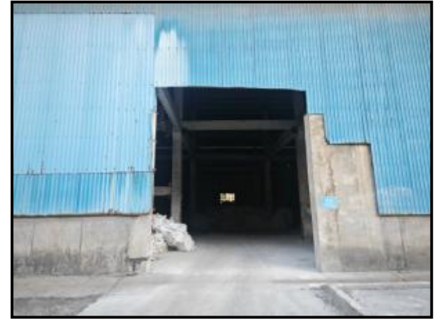
现有一般固废暂存库
