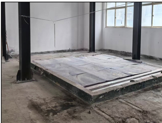
厂房西南现有事故池
