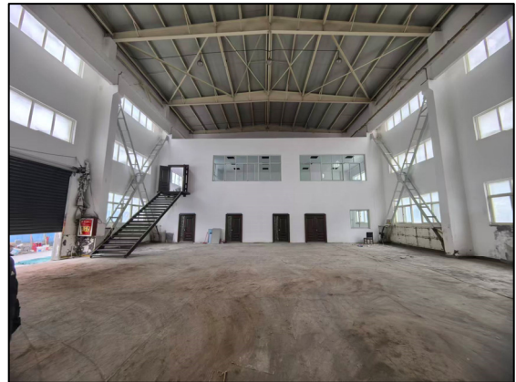
北侧现有辅助用房
