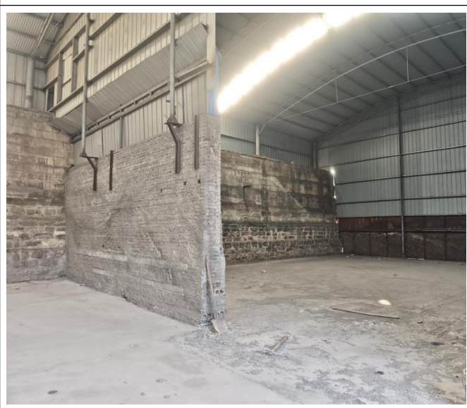
项目厂房内现状照片
