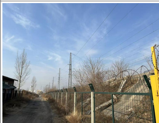
项目北侧焦枝铁路
