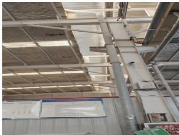
有机废气排气筒
