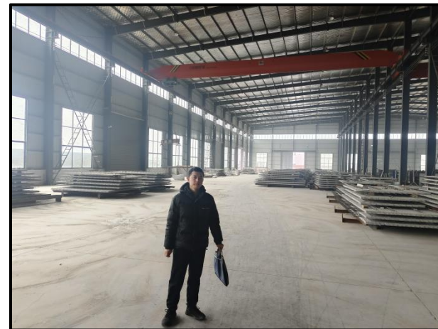
工程师现场勘察
