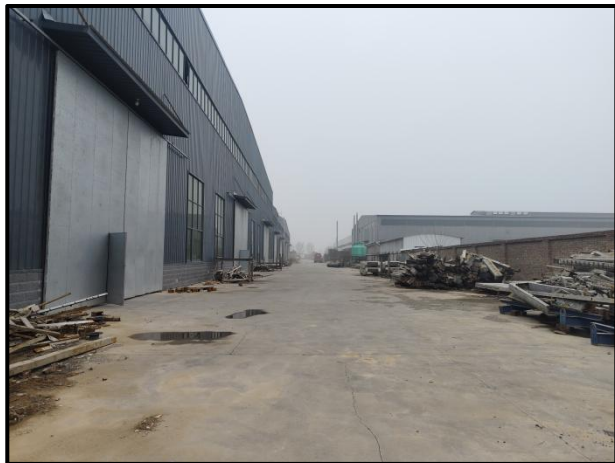
项目租用厂房外部
