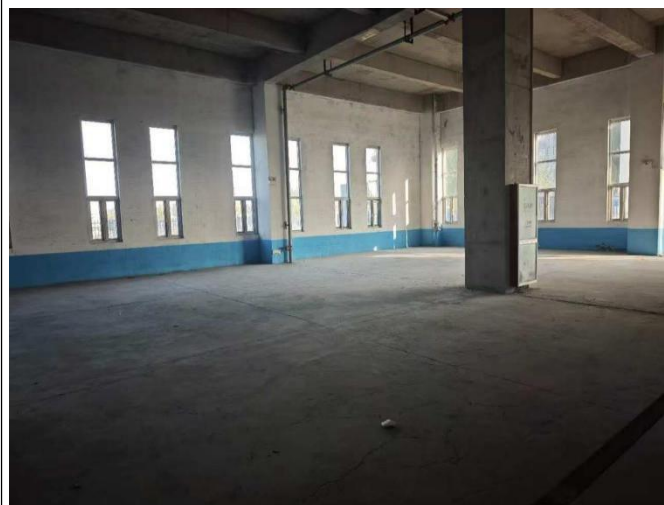
厂房内部照片
