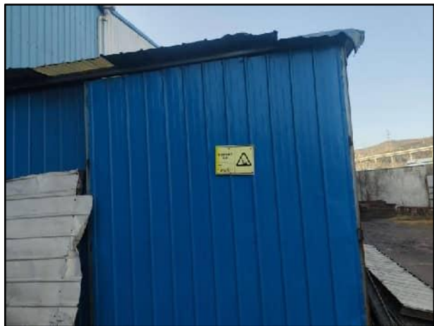
现有危废暂存库
