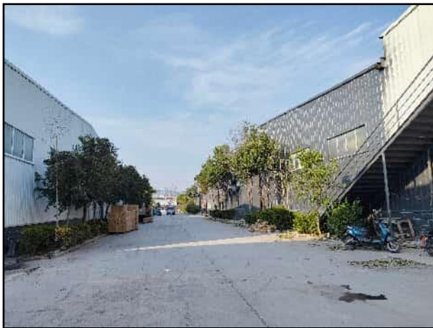
项目所在厂区现状
