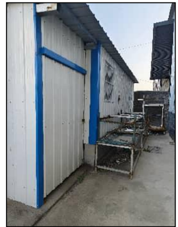
现有工程危废暂存库及一般固废暂存库
