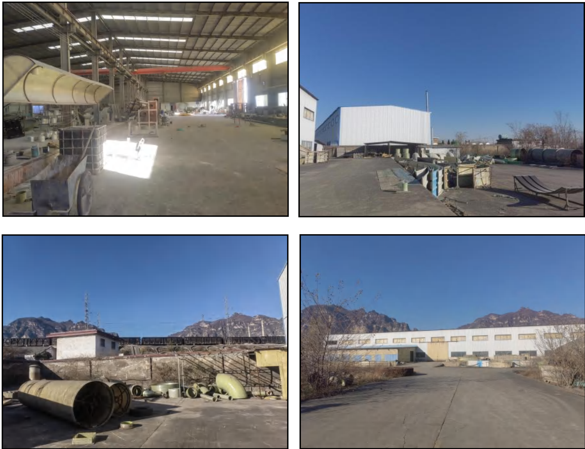
图 4.2-4 生产车间及车间外硬化现场图
