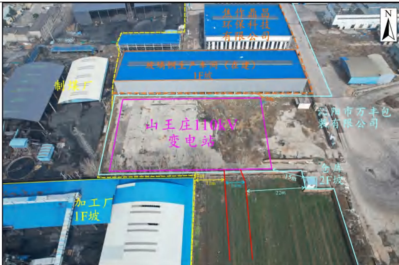
图 3-6 本项目拟建站址及输电线路周边环境敏感目标现状航拍图
