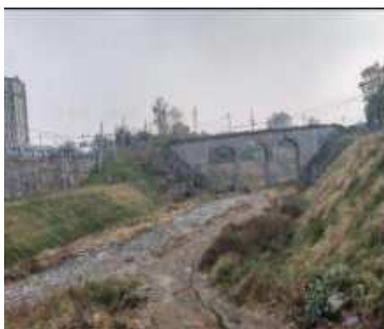
厂区东南白马门河
