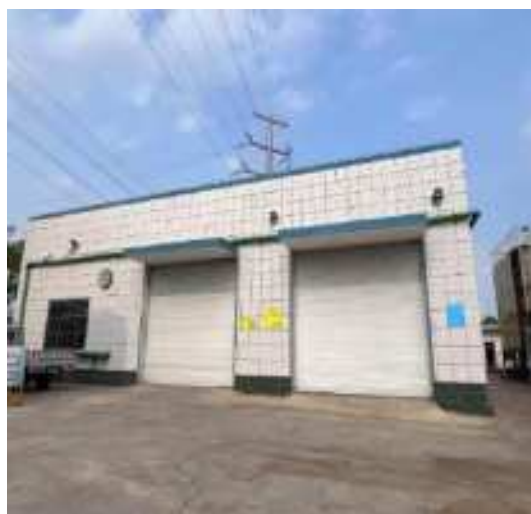
危废暂存间（利用现有）
