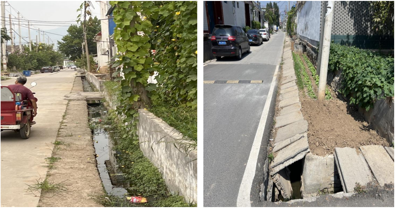
图 5.2-1 现状排水沟渠情况
