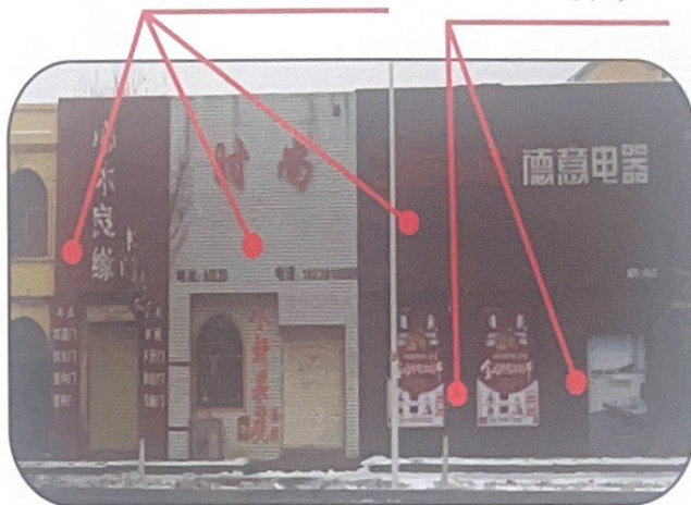
立柱过度装修
