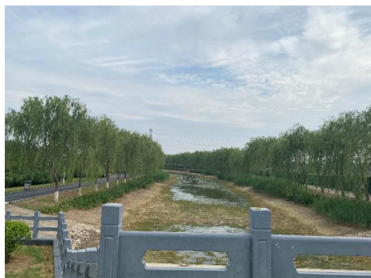
沁北干渠清淤后照片
