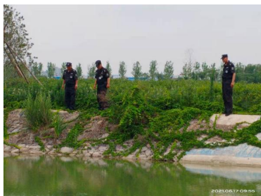
沁北干渠引水照片
