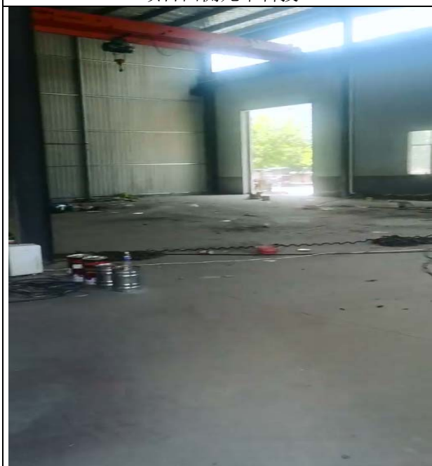
项目租用车间现状
