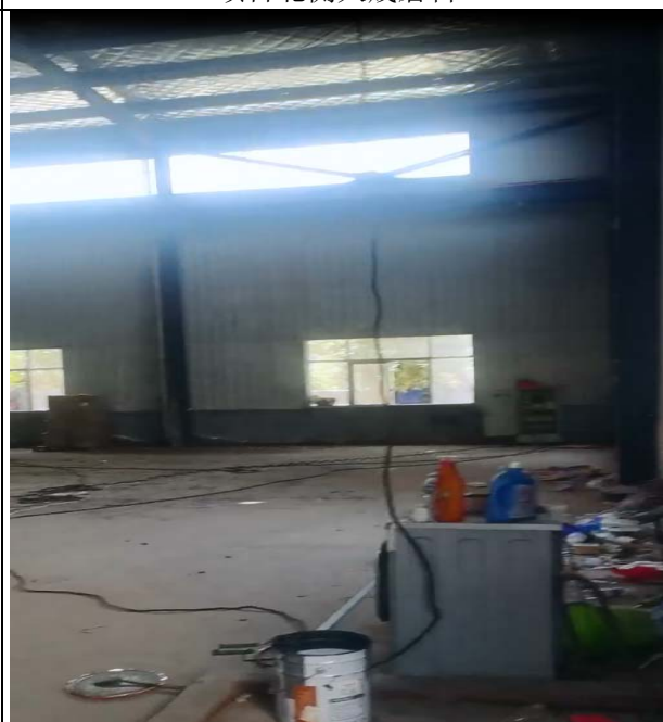
项目租用车间现状
