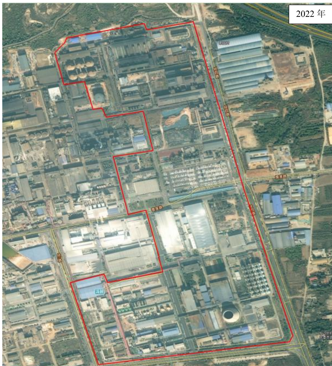
2022 年 8 月厂区所有项目建设完成
