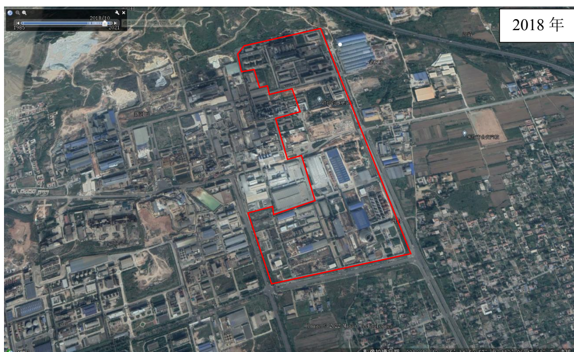
2018 年 10 月厂区所有项目建设完成
