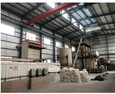
大修渣车间（车间设备已拆除，用作备件仓库）
