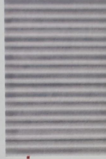
银灰色波形金属板 施工工艺：安装固定
