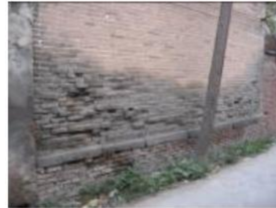
图 4.16 砖石混合台基
