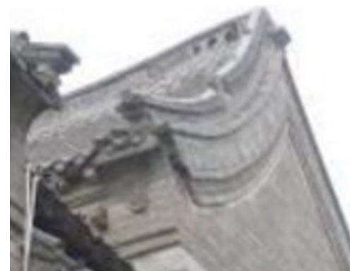
山墙顶部处理
